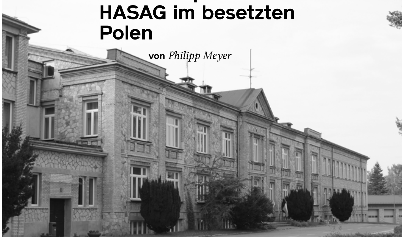
Das ehemalige Verwaltungsgebäude der HASAG, heute Sitz des Rüstungskonzerns Mesko
