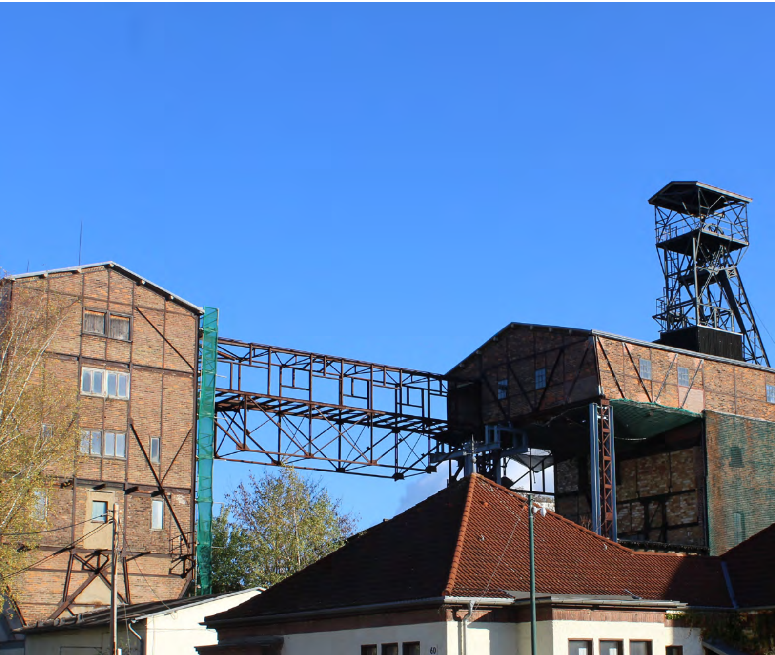
↗ Schacht Dölitz (Martin Baumert)
