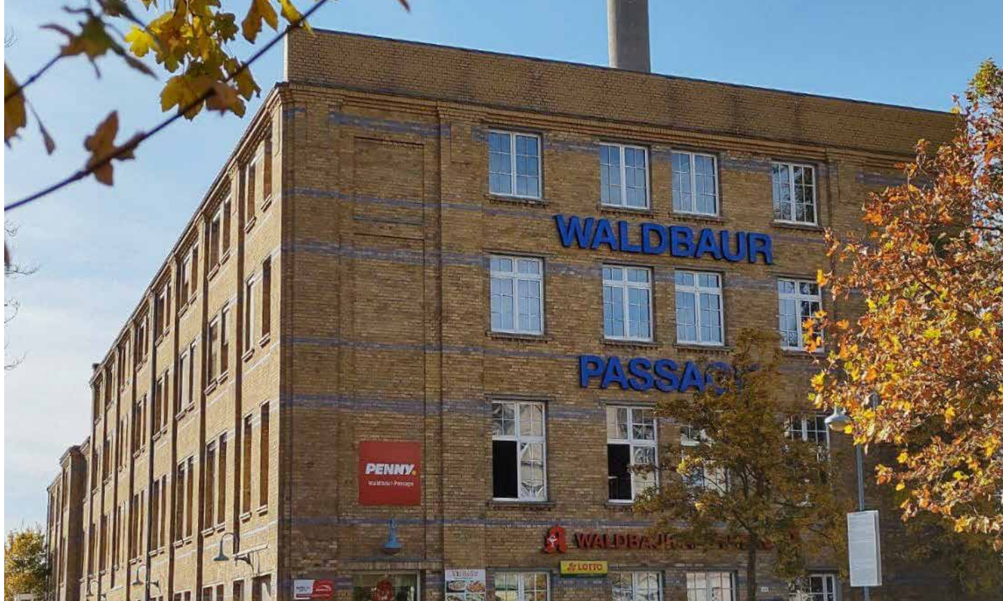
↗ Das ehemalige Fabrikgebäude in der Waldbaurstraße 4–6 (Kathrin Weiss)
