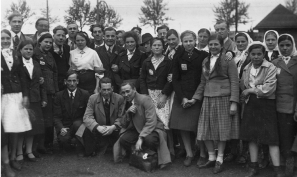
↑ Niederländische Zwangsarbeiter und „Ostarbeiterinnen“ auf dem Gelände der HASAG, 1943 (Bild: GfZL)
